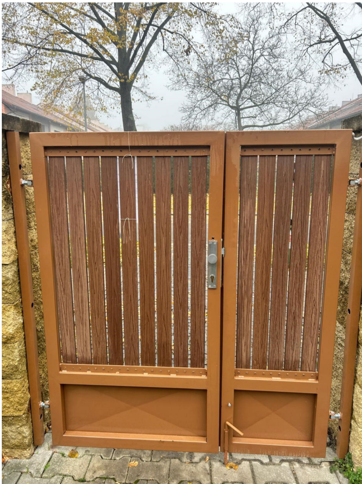
MŠ Kostičky - oprava podlah a dveří
